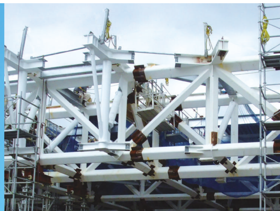
鋼構造屋根(角型鋼)
